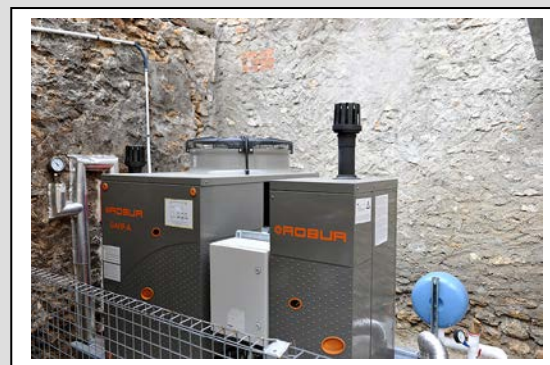
PAC Gaz et chaudière à condensation
