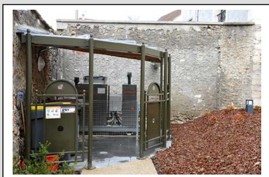
PAC Gaz et chaudière à condensation
